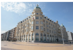
Baron de Maerelaan 2, ZEEBRUGGE EPC B
