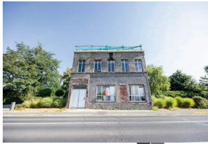
Kapelstraat 101, BOOM EPC F
