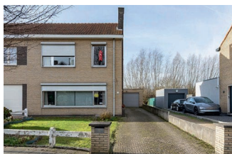
Meidoornlaan 15, EREMBODEGEM EPC E
