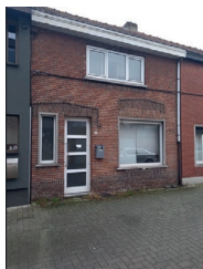
Nieuwstraat 68, BORNEM EPC F
