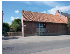
Westvleterendorp 18 A, WESTVLETEREN EPC F
